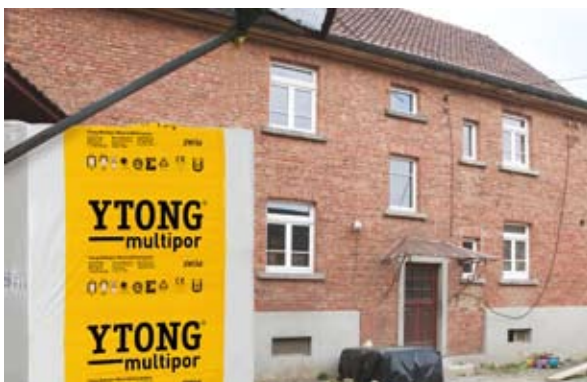
Ein Altbau wird zum Niedrigenergiehaus.
