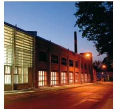
Wiederaufbau der alten Weberei, Fulda, nach einem Brand: Innendämmung mit dem Ytong Multipor Mineraldämmsystem
