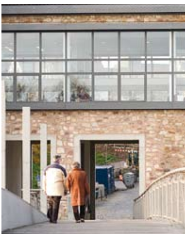
Vorhandene Portale neu integriert
