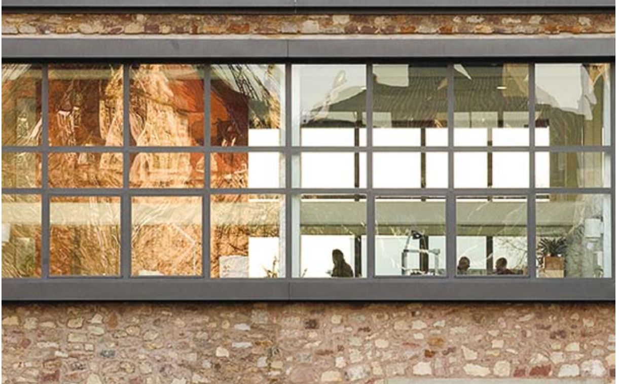
Renthof, Kassel – moderner Wärmeschutz in historischem Gebäude
