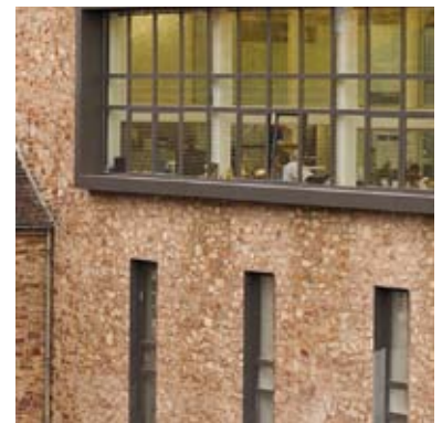
Hightech hinter denkmalgeschützter Fassade
