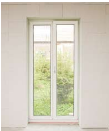
Innendämmung von Außenwänden mit Ytong Multipor Mineralfolienplatten ermöglicht die erfolgreiche Verwandlung eines fast 80 Jahre alten Bauernhauses.
